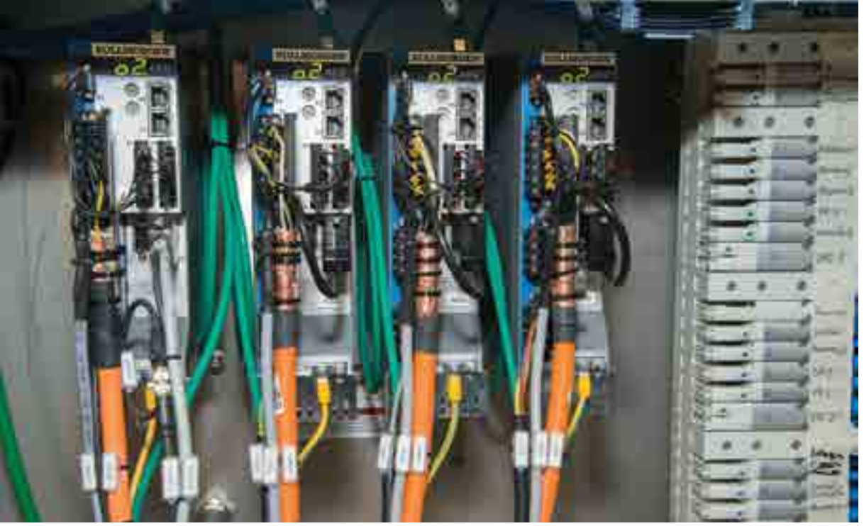
KOLLMORGEN Servo sürücü AKD motora tek kablolu bağlantı teknolojisi ile bağlı.
