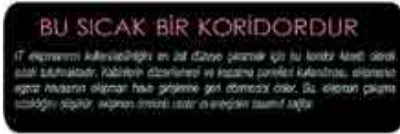
Şekil 4 Sıcak koridorun amacını açıklayan etiket
