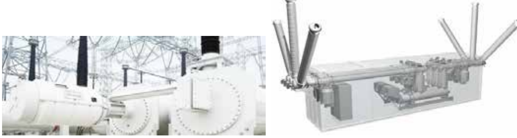
Şekil 5: Jingmen Çin – 1100kV Ultra Yüksek Gerilim Tesisi ve 420kV Mobil YG Tesis
