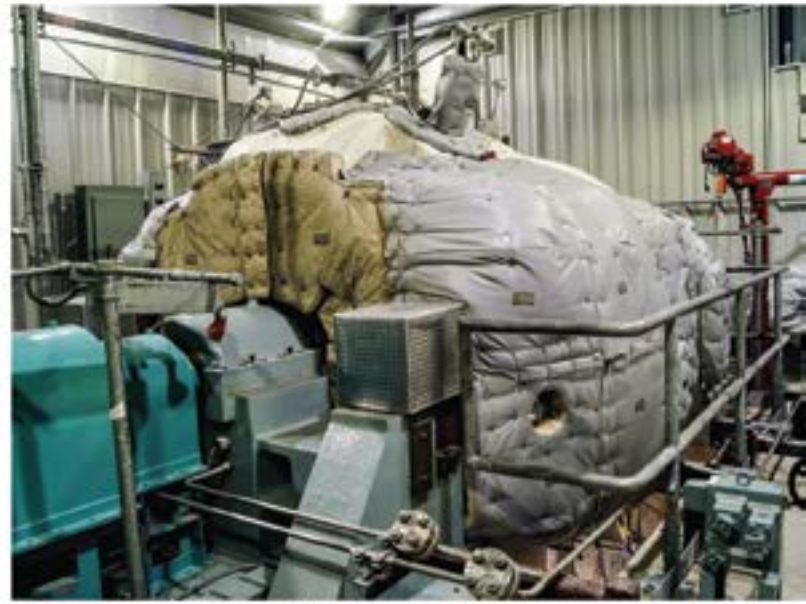
Kızgın madde: NET Power'ın Allam döngülü santralindeki Toshiba yapımı türbin, kızgın süper-kritik CO 2 'yle çalışmak üzere özel kaplama ve yalıtımla güçlendirilmiş. Ebadı yaklaşık olarak bir aile minibüsü kadar olan türbin, gücüne oranla son derece küçük sayılır. Firma bunu satış açısından önemli bir özellik olarak görüyor.
